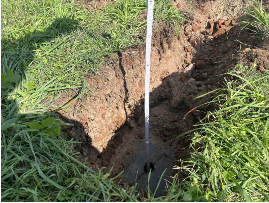
Abbildung 9: Schurf mit freigelegter Folienabdeckung
