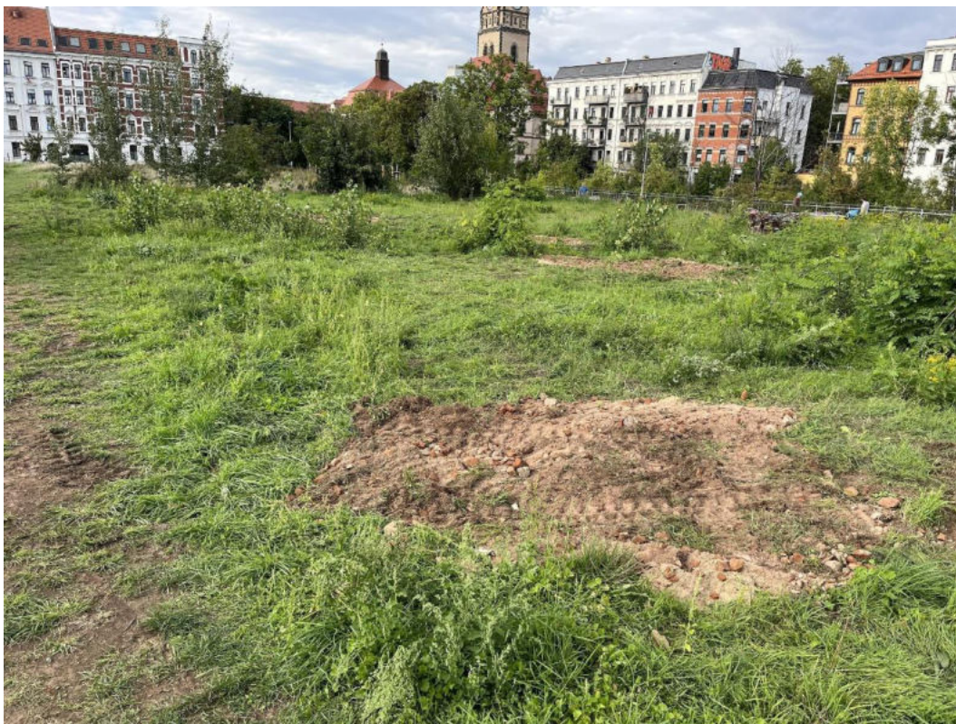
Abbildung 16: Verfüllung der Schürfe, Oberflächenanpassung an das Gelände
