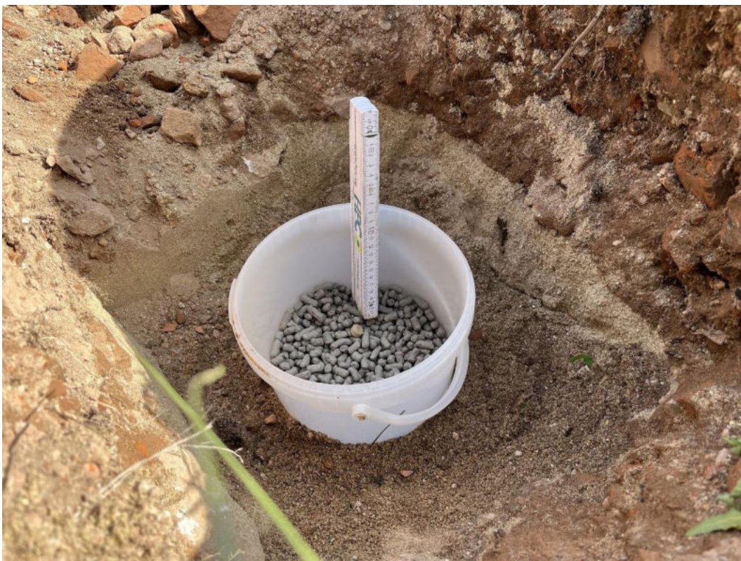
Abbildung 14: Verfüllung/Überdeckung der Folie mit Sand
