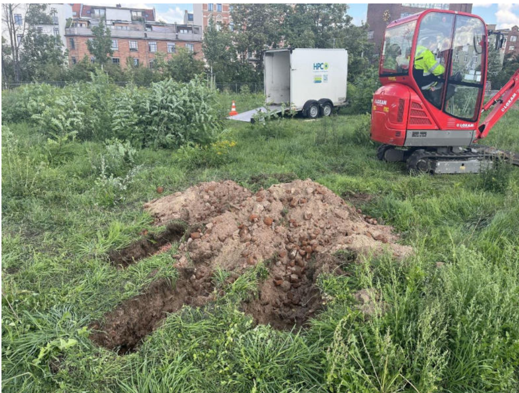
Abbildung 8: Herstellen der Schurfe
