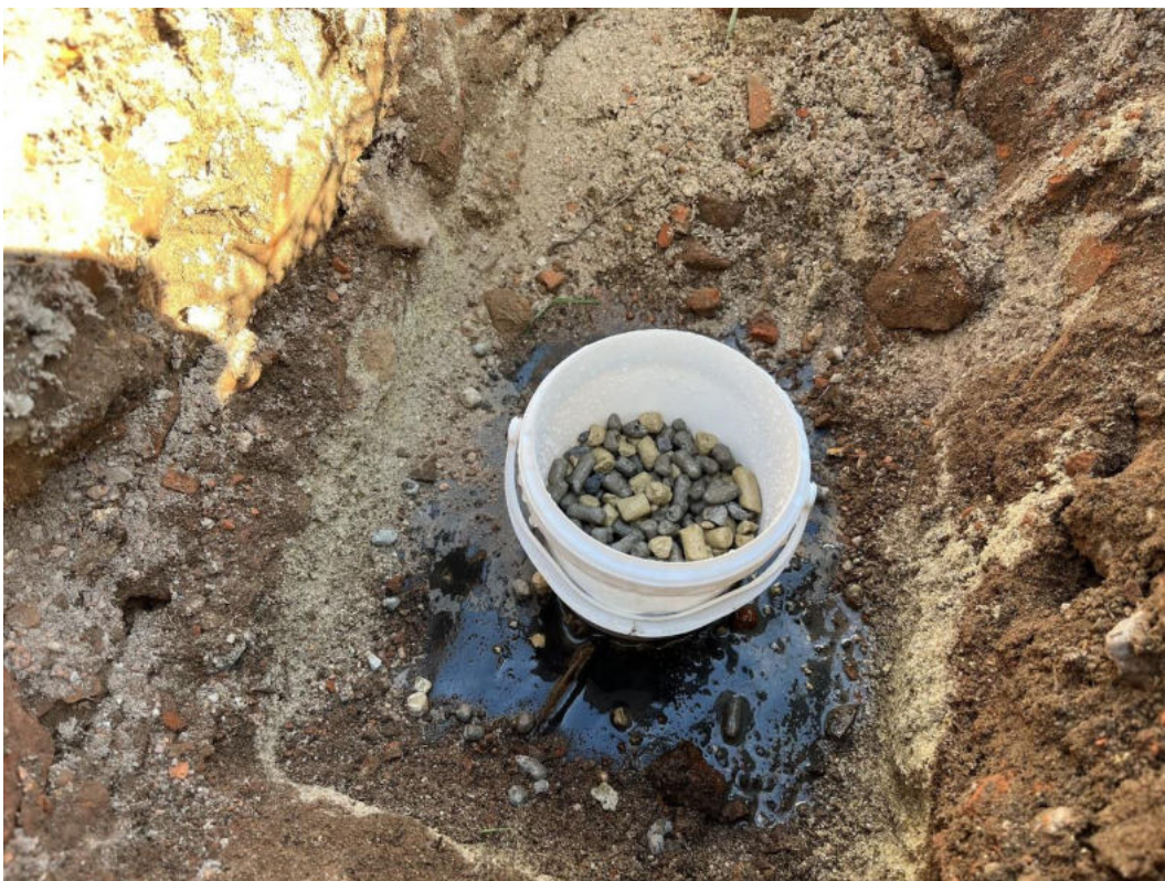
Abbildung 12: Verfüllung mit Tonpellets, Wässern, Aufquellen der Tonpellets
