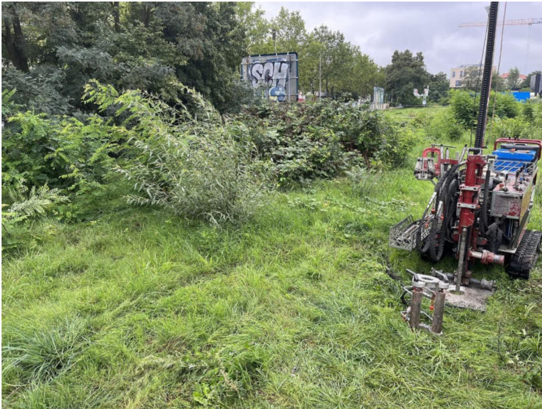
Abbildung 3. Sondierarbeiten im Bereich der Sondierung 1/22
