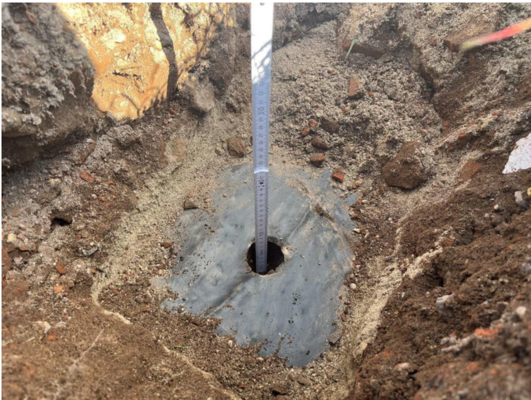
Abbildung 10: Schurf mit freigelegter Folienabdeckung, Abmessung unterhalb der Folie
