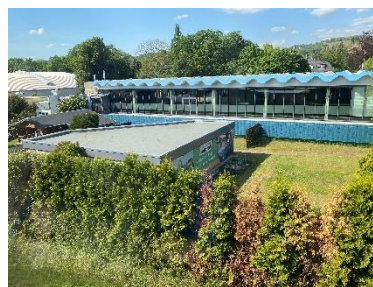
Sporteinrichtungen (Schwimmhalle) (Quelle: STEG)
