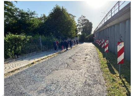
Richard-Wagner-Straße – Gehweg am Haltepunkt Radebeul-Weintraube (Quelle: STEG)
