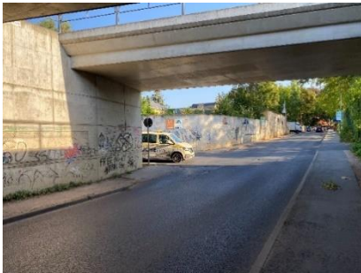
Weintraubenstraße - Gehwege an Unterführung (Quelle: STEG)
