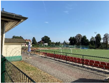
Lößnitzstadion (Quelle: die STEG)
