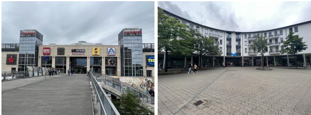
Abbildung 45: B-Zentrum Stuttgarter Allee
