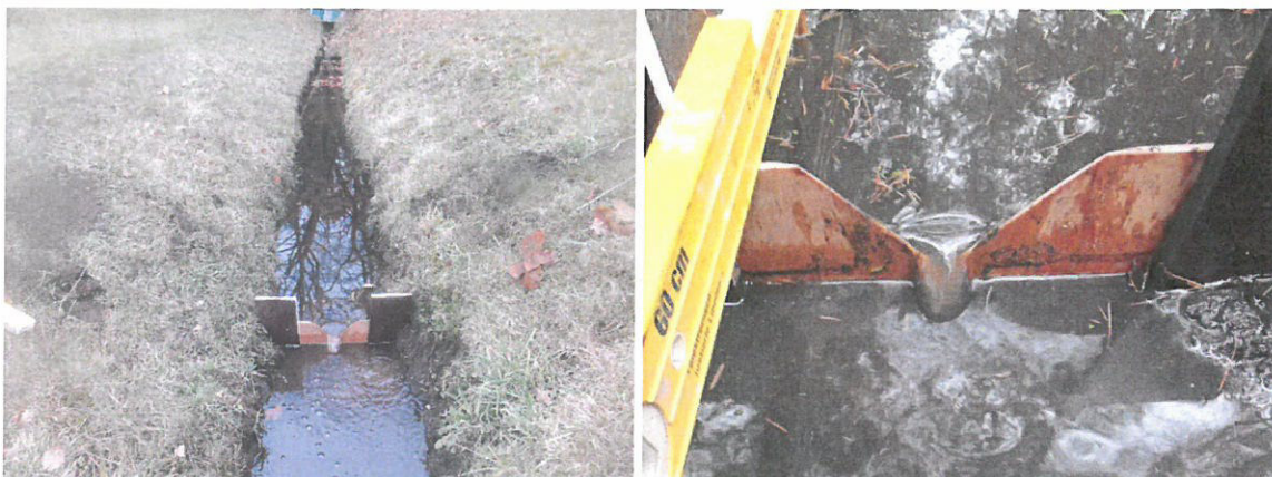
Abb. 5: Durchflussmessung Kontrollpunkt 1 (links) und 7 (rechts)
