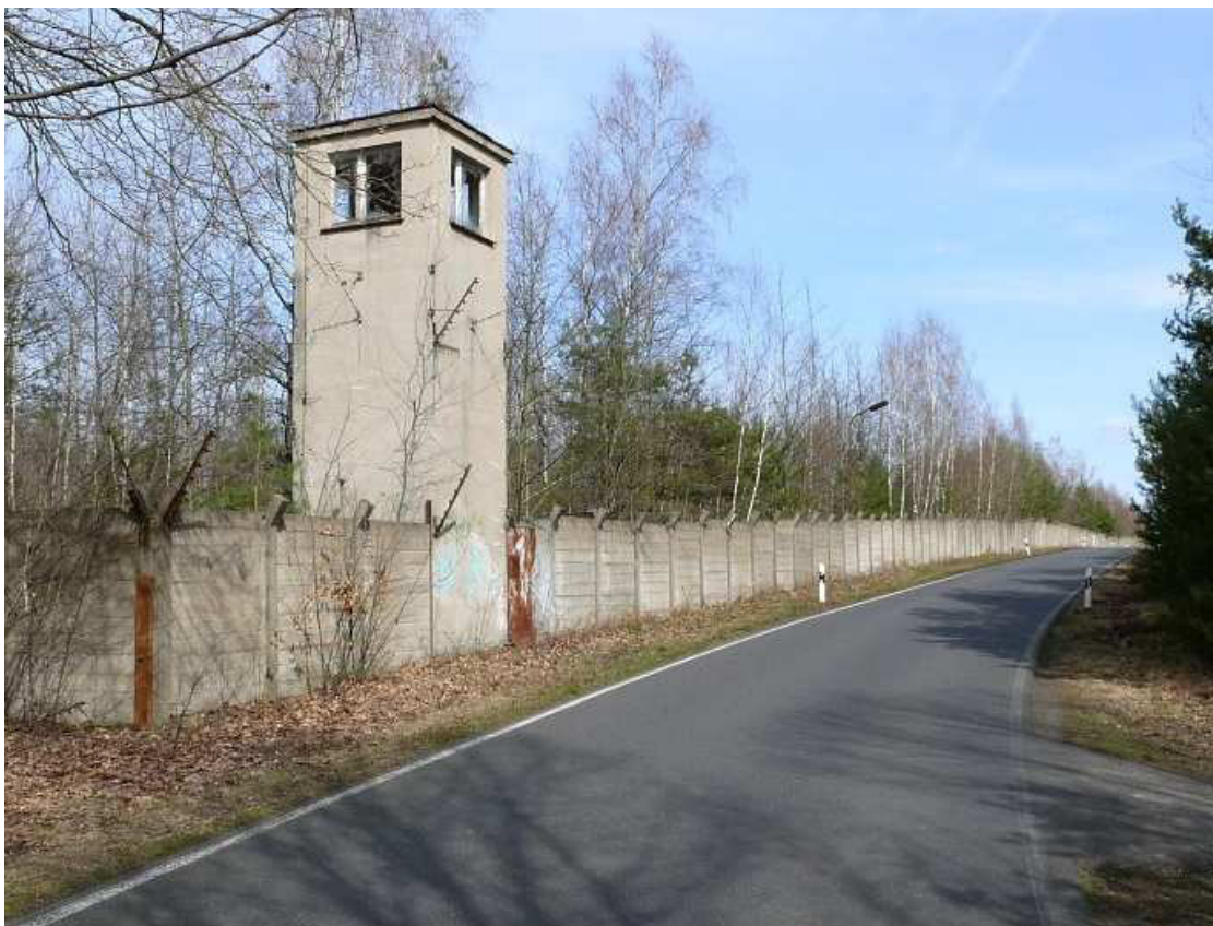
Abb.: Blick auf die östliche Objektmauer mit Postenturm
