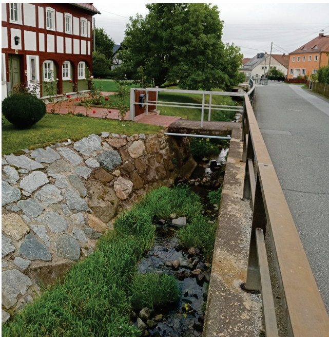
Abbildung 6.6: Einengung des Gerinnes an der Brücke Nr. 34 bei km 4+469
