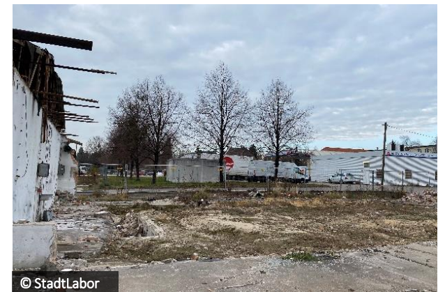
Abriss ehemaliger Gebäude der Gärtnerei (2019/20)
