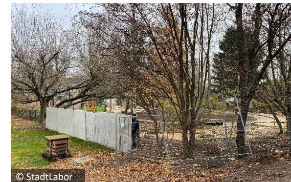
Blick von der Reicker Straße: Baustelle des neuen Spielplatzes der Kindertagesstätte (November 2020)
