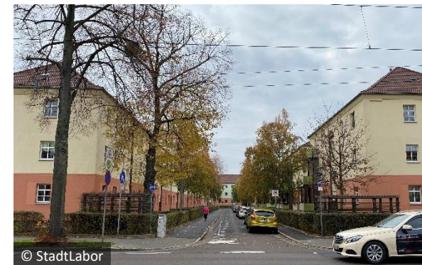
© StadtLabor Siedlungsbau an der Reicker Straße (Wieckestraße), ebenfalls östlich des Gebiets
