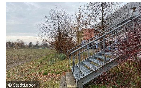
Fluchttreppe als symbolische Verbindung zwischen O.D.C. und Brache
