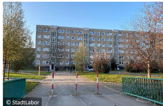
Fußgängerbrücke über den Koitschgraben verbindet zwei Wohnsiedlungen miteinander
