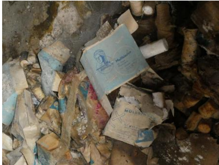
Gebäude 5 - mit Resten der eingelagerten Materialien (Verbandsmaterial)
