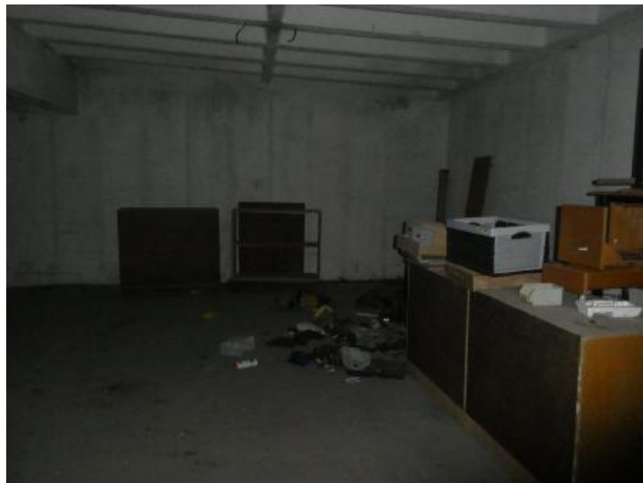
Gebäude 16 mit abgestellten Möbeln, keine organoleptischen Auffälligkeiten
