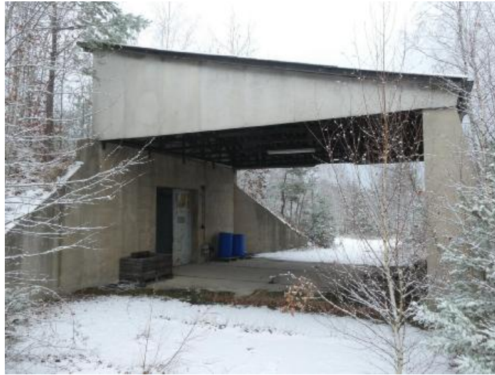
Gebäude 16 - Bunker, 1 Raum, draußen 2 leere Fässer
