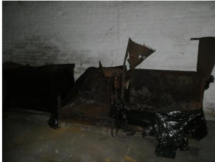
Gebäude 11 - rechter Raum, Lagergebilde für Speisesalz und Akkusäure
