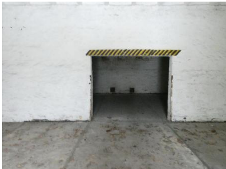
Gebäude 2 - Lagergebäude, 2 Räume, keine organoleptischen Auffälligkeiten
