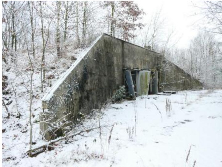
Gebäude 19 - Bunker, 1 Raum, leer
