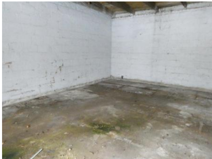
Gebäude 1 - Lagergebäude, rechter Raum, keine organoleptischen Auffälligkeiten
