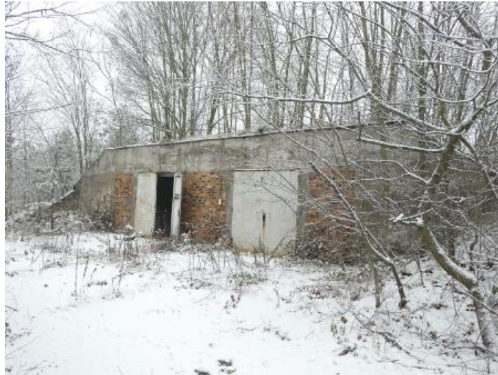
Gebäude 23 - Bunker, 1 Raum, leer
