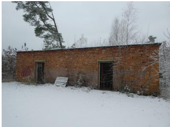
Gebäude 6 - Kleines Lagergebäude, 2 Räume, ehem. Lager für Getriebeöl und Kochbadflüssigkeit
