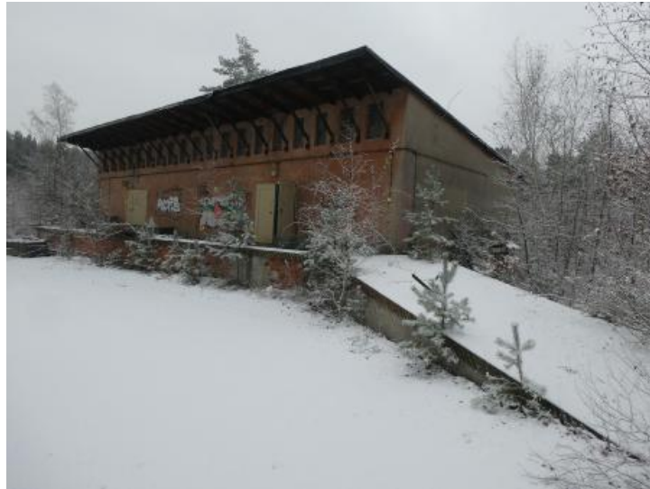
Gebäude 10 - Lagergebäude, 2 Räume, keine organoleptischen Auffälligkeiten, Abfälle
