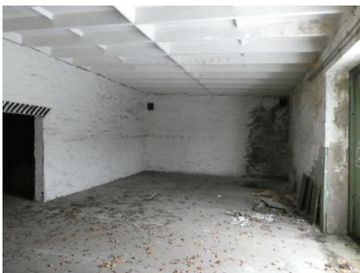
Gebäude 4 - Lagergebäude, 2 Räume, keine organoleptischen Auffälligkeiten
