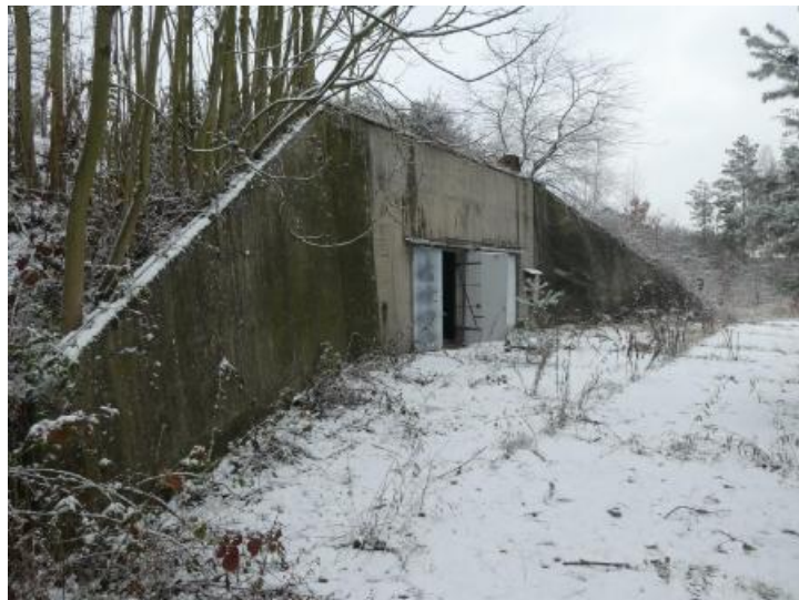
Gebäude 18 - Bunker, 1 Raum, leer
