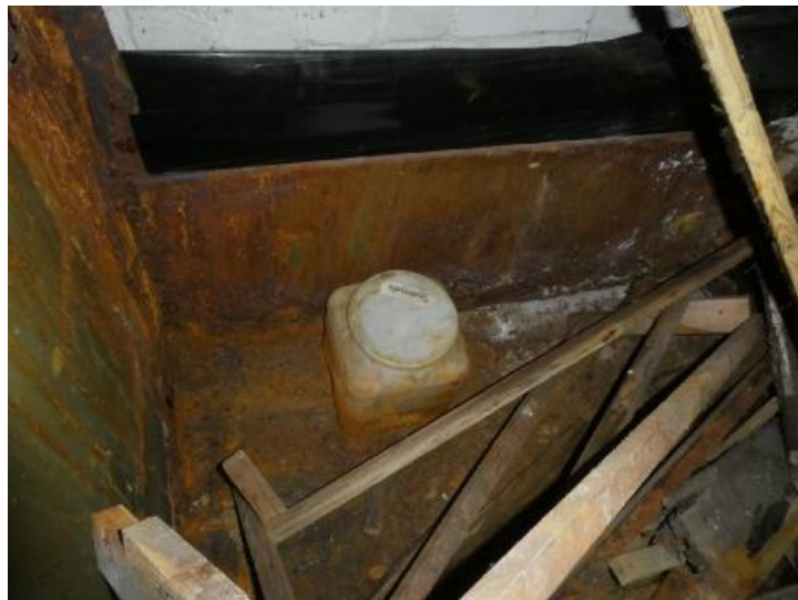
Gebäude 11 - rechter Raum: Lagerbehälter für Speisesalz
