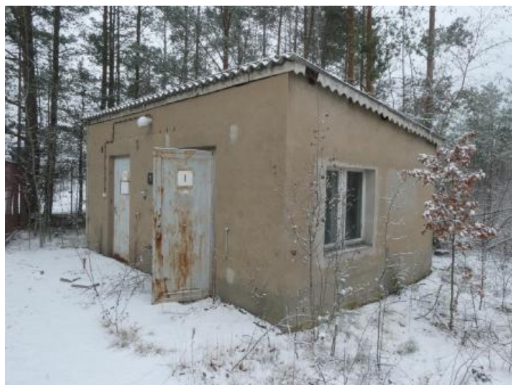
Gebäude 15 - Pförtnerhaus, 2 Räume, linker Raum verschlossen, rechts keine Auffälligkeiten
