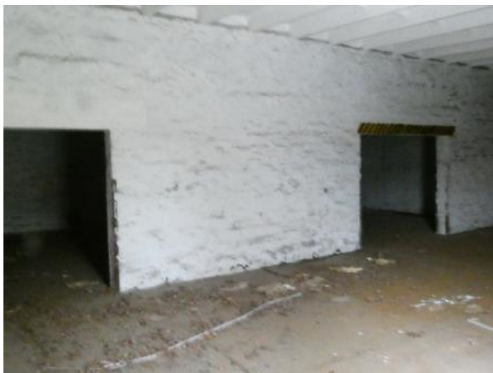
Gebäude 3 - Lagergebäude, 2 Räume, keine organoleptischen Auffälligkeiten
