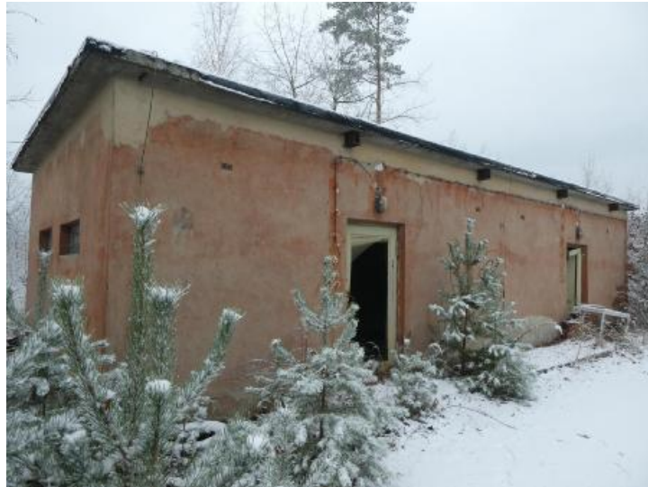
Gebäude 7 - Kleines Lagergebäude, 2 Räume, keine organoleptischen Auffälligkeiten
