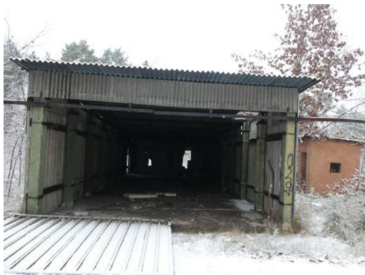
Gebäude 8 - Lagergebäude mit Nebengebäude, keine organoleptischen Auffälligkeiten
