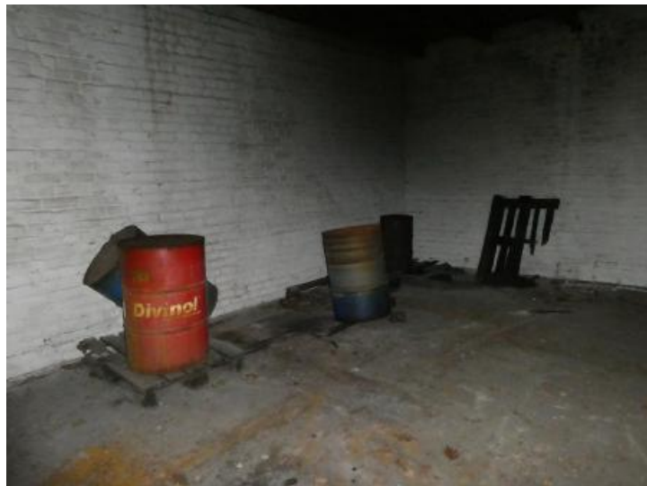
Gebäude 11 - rechter Raum: noch gefüllte Ölfässer (Divinol)
