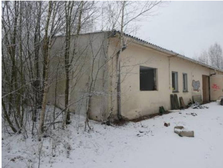
Gebäude 9 - Lagerhalle, zuletzt Tanzclub, mehrere Räume, stark verwüstet durch Vandalismus und illegale Ablagerung von Abfällen
