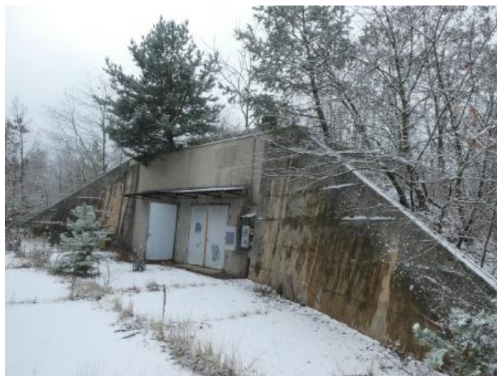
Gebäude 17 - Bunker, 1 Raum, leer
