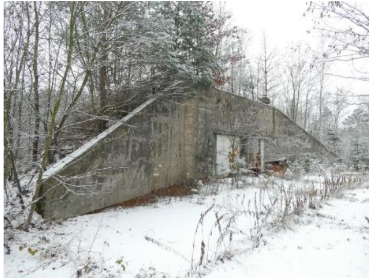
Gebäude 22 - Bunker, 1 Raum, leer
