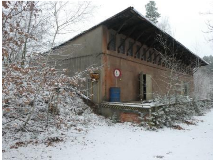
Gebäude 11 - Lagergebäude, linker Raum leer, rechter Raum Lagerung von Öl und Akkusäure, draußen Fass für Flugbenzin
