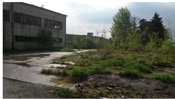
Foto 6: vorhandene Halle, ruderaler Bewuchs im Umfeld
