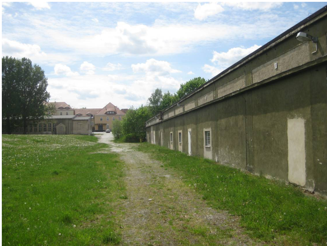
Abbildung 5: Unsanierete Altgebäude am südwestlichen Rand des Plangebietes
