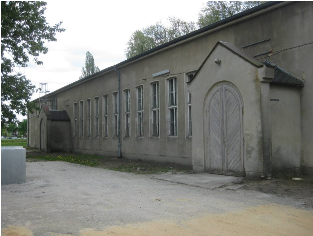
Abbildung 8: Altgebäude am Siedlungsweg
