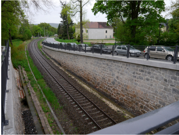
Abbildung 2: Bahnstrecke Kamenz-Pulsnitz, Barmherzigkeitsstift, Nordfassade
