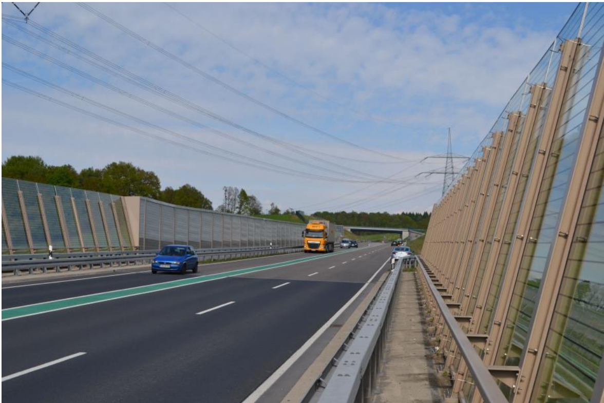
Abbildung 21: Staatsstraße S 177 südlich Pirna, Brückenbauwerk 10 über den Bonnewitzer Grund mit Lärmschutteinrichtung
