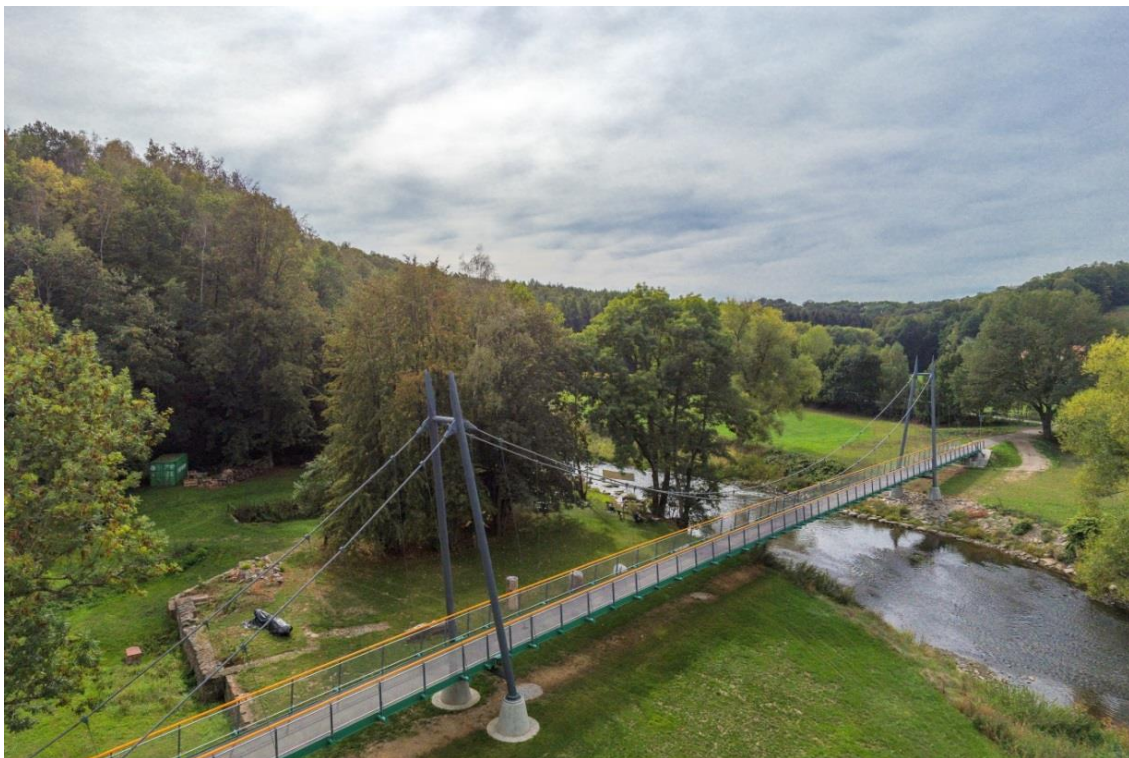
Abbildung 10: B 107 Chemnitztalradweg, Bauwerk 10
