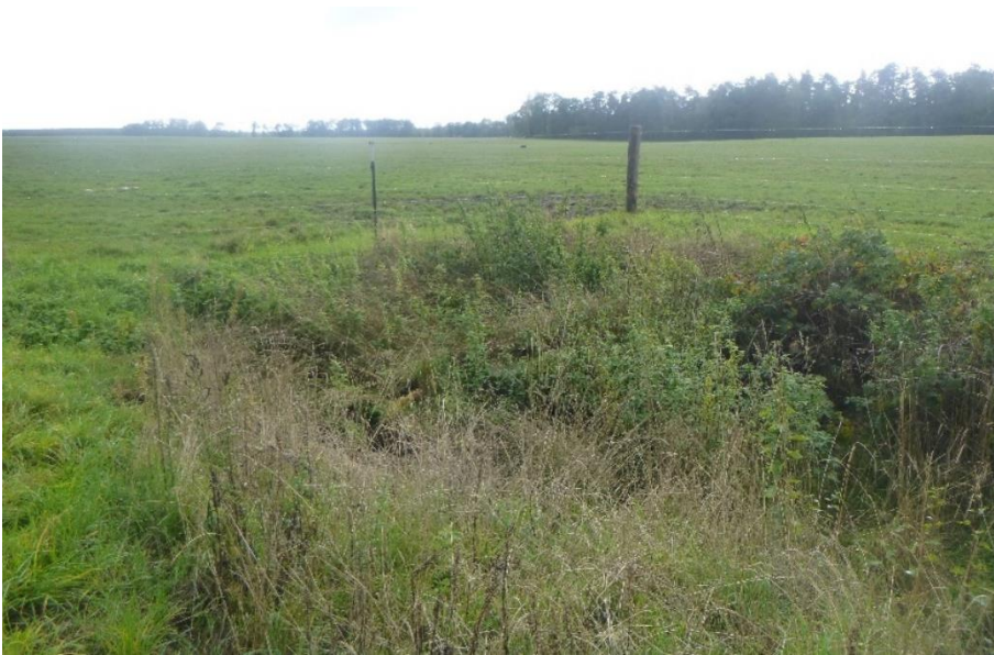
Bild 50: Blick stromaufwärts am Endpunkt des OWK Hauptvorfluter Bloischdorf ohne erkennbaren oberirdischen Fließverlauf (Foto: Henrich, 16.10.2020).
