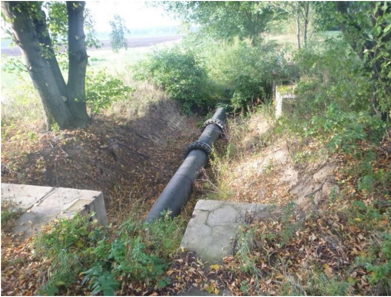
Bild 56: Verrohrter Abschnitt des OWK Legnitzka an der Messstelle FG_EL_02 der LEAG, Foto: Knauf, 24.09.2020.
