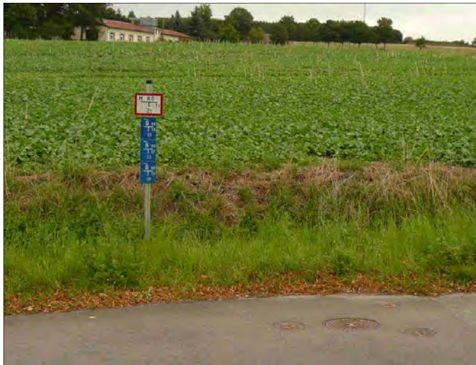
Abb. 28: Unterflurhydrant Schafberg
