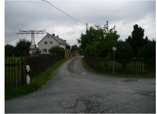
Zufahrt nach Norden in die Siedlung mit 110 kV Leitung
